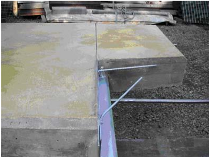
(Kuva 2) Valmis liikuntasauva kitataan kun betonin kutistuminen on tapahtunut. Kutistumisaika on n. 6-10 viikkoa lämpötilasta riippuen.
