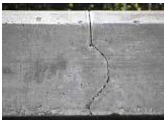
(Kuva 2) Valmis liikuntasauva kitataan kun betonin kutistuminen on tapahtunut. Kutistumisaika on n. 6-10 viikkoa lämpötilasta riippuen.
